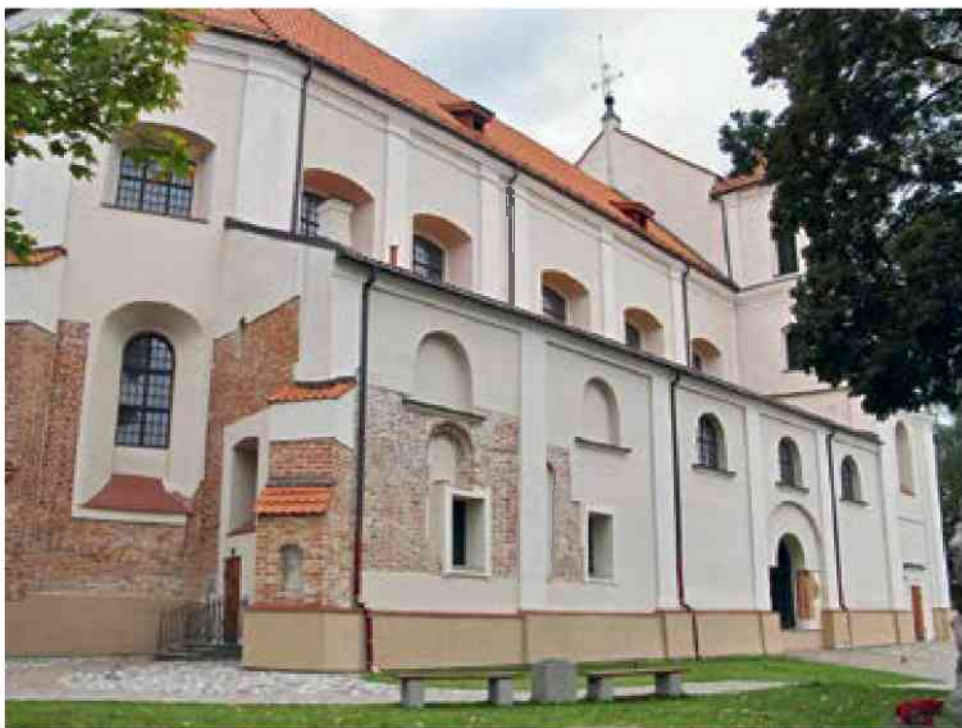
Ил. 25. Приходский костел Посещения Пресвятой Девы Марии в Троках (Тракай). Северный боковой фасад. Основан великим князем Витовтом в 1409 г., возведен около 1419 г., апсида с восточной стороны пристроена после 1497 г., крыльцо к западному фасаду – в 1610 г.; реконструирован во второй половине XVII в. Фотография Г. Мицкунайте
