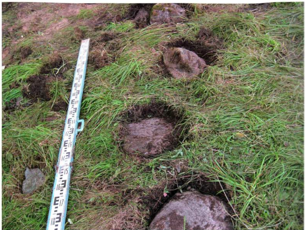
Іл. 13. Фрагмент лініі падмурка ўсходняй сцяны Мікольскай царквы (паміж шурфамі 3 і 1). Выгляд з боку шурфа № 3
