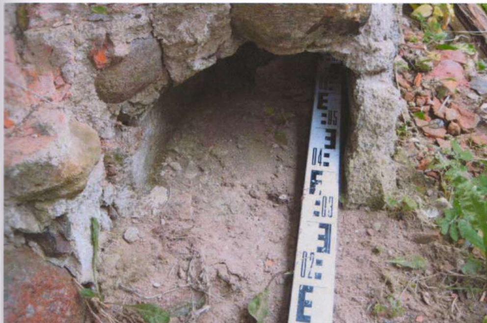
Мал. 26. Княская вежа. Паўднёва-ўсходняя сцяна. Арматурны канал. Выгляд з паўночна-ўсходняга боку
