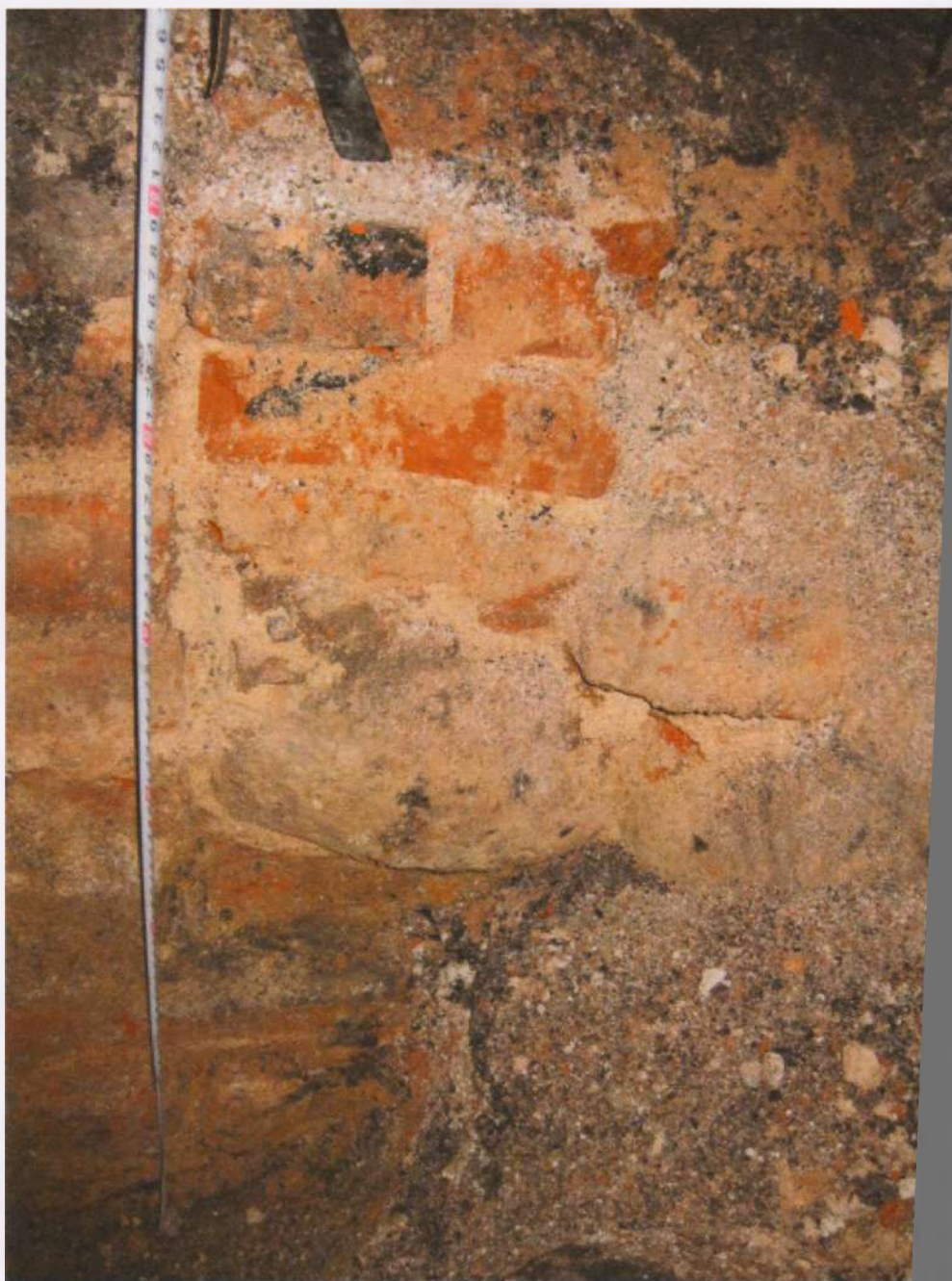
Мал. 39. Шурф 1. Кв. 10. Перевязка паміж перамычкай і падмуркам слупа. Выгляд з паўночнага захаду (разрэз Б-Б)
