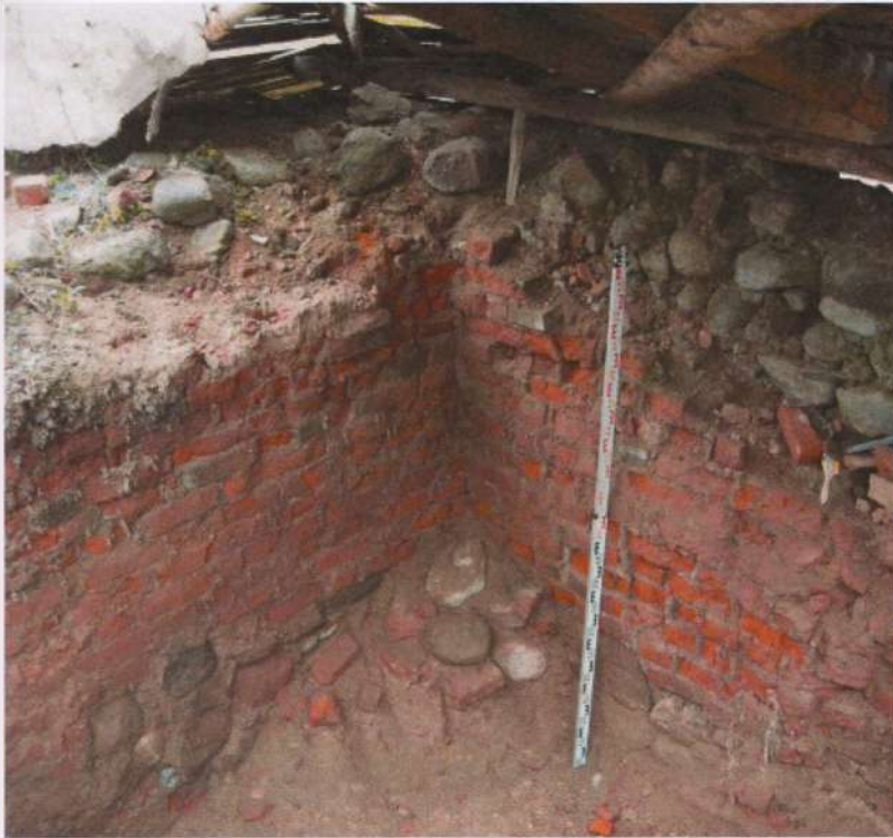
Мал. 31. Шурф 2. Усходні кут шурфа (С). Забутоўка скляпення
