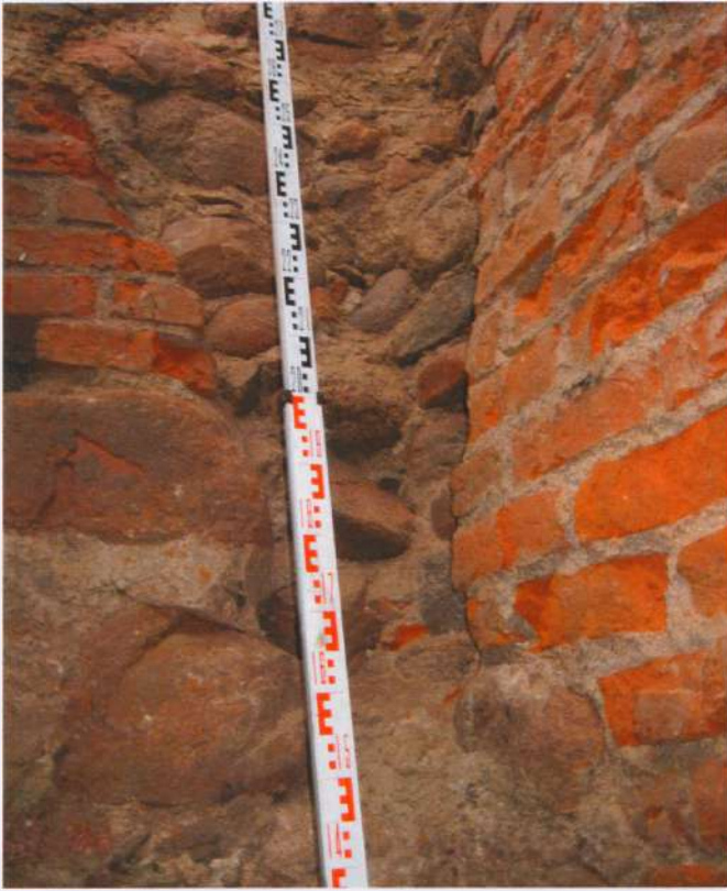
Мал. 34. Шурф 2. Усходні кут шурфа (С). Унутраны кут вежы, выкладзены з камянёў
