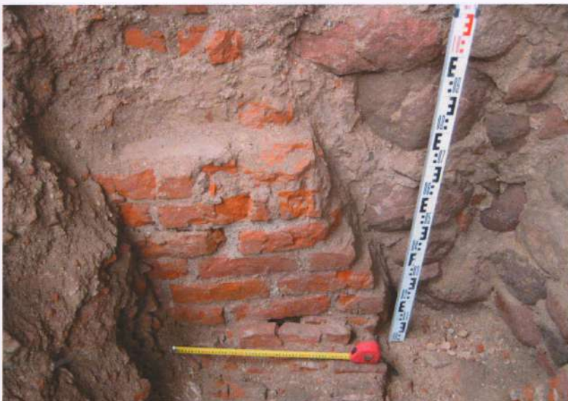
Мал. 32. Шурф 2. Усходні кут шурфа (С). Паўночна-ўсходняя сцяна ў працэсе раскопак. Падспружная арка ля сцяны вежы
